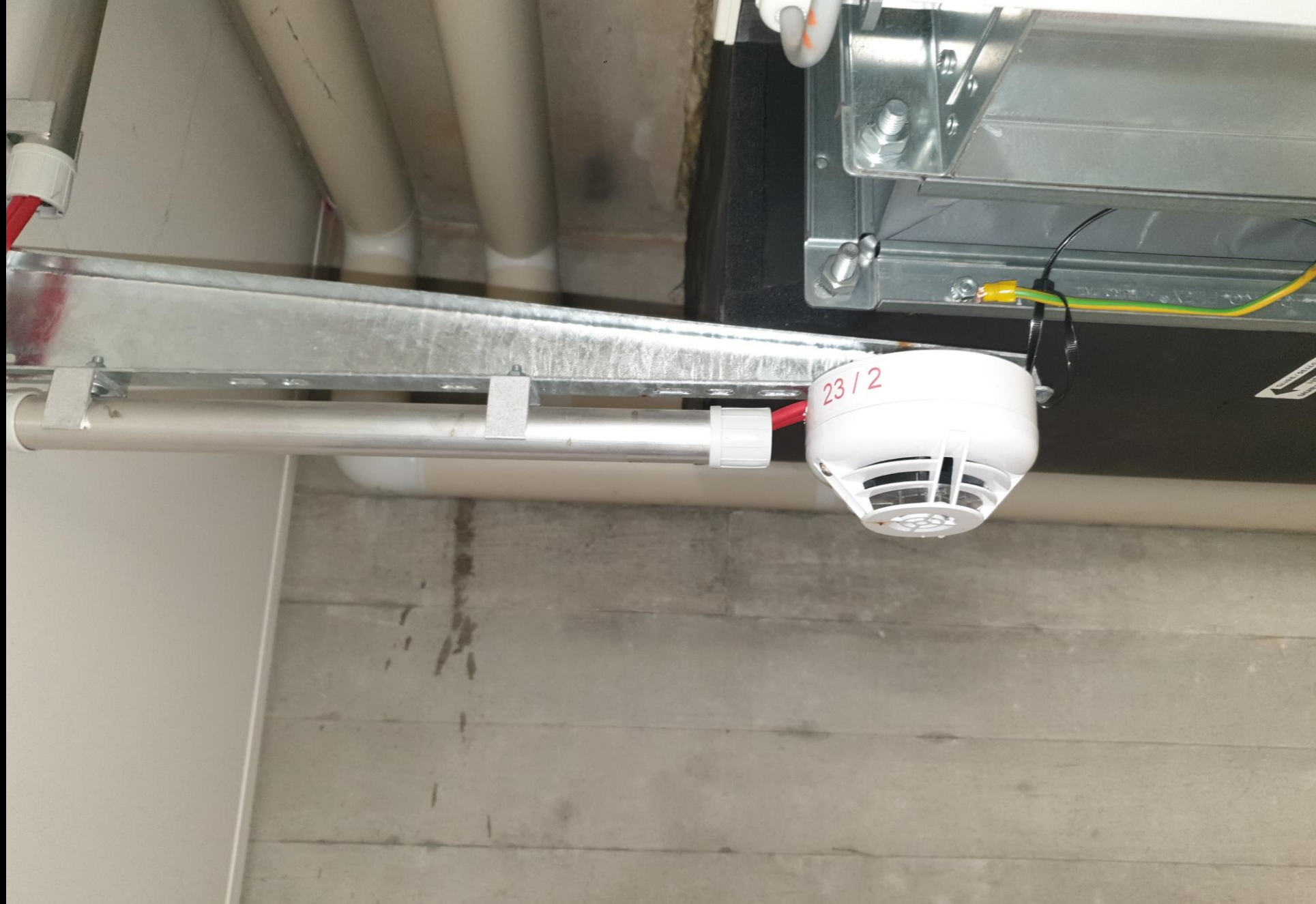
14.01.2025 - BMA Feuerwehrhaus, Lauffen am Neckar
