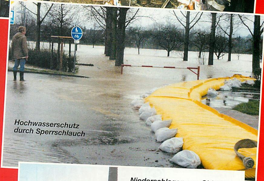
Hochwasserschutz durch Sperschlauch
