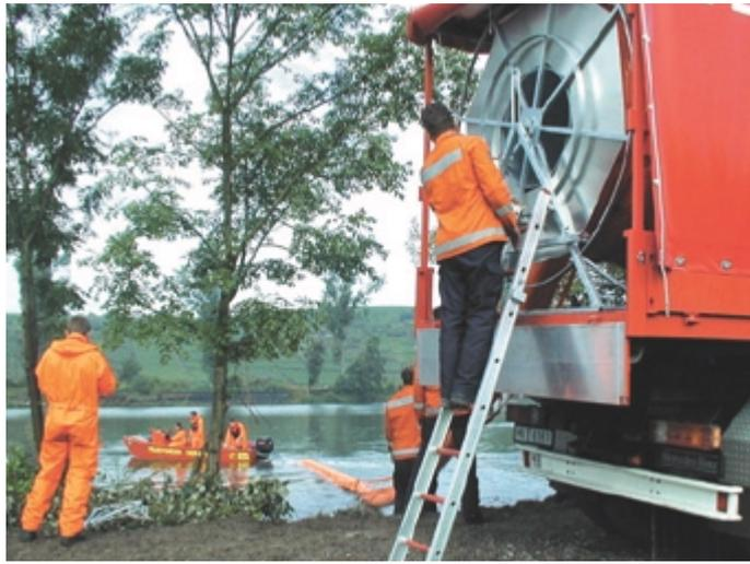
Sperre ermöglicht einen Einsatz in Gewässern bis zu einer Fließgeschwindigkeit von zwei Metern je Sekunde sowie in sehr seichten Gewässern. Durch die Standartlänge der einzelnen Elemente von 10 Metern können diese auch in kleinere Flüsse bzw. Bäche zur Eingrenzung von Ölmengen eingebracht werden.
