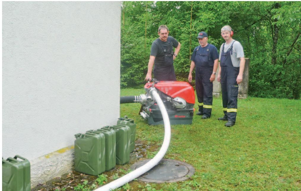
Eine Mammutaufgabe für Material und Mensch stand bei der Erstbefüllung des neuen Wasserhochbehälters „Nord“ an. Über 300 m³ Wasser mussten vom Behälter Schlossberg auf 1,2 km Länge und über 90 Meter Höhenunterschiede in acht Stunden Dauerbetrieb gepumpt werden.
