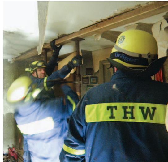
Mit Kanthölzern und Stahlstützen wurde die Decke abgesprießt.
